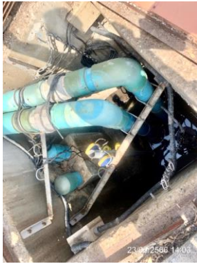
เครื่องสูบน้ำสำหรับระบายน้ำสู่ท่อระบายสาธารณะ ด้านหน้าโครงการ
