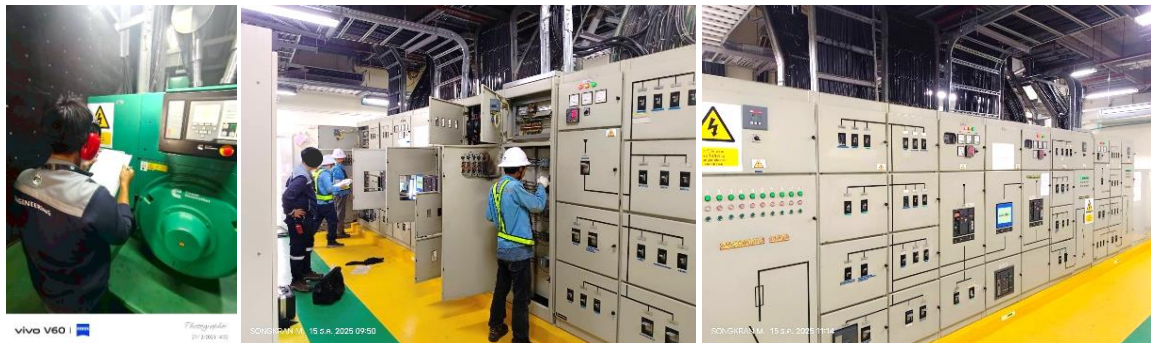
รูปที่ 2-18 เจ้าหน้าที่ตรวจสอบเครื่องกำเนิดไฟฟ้าสำรอง และแผงควบคุมไฟฟ้าของโครงการ
