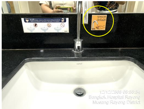
รูปที่ 2-20 ก๊อกน้ำอัตโนมัติ
