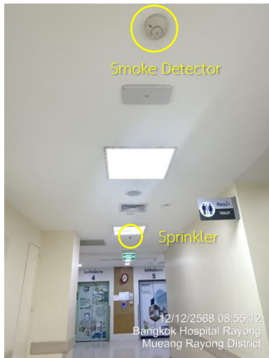
เครื่องตรวจจับควัน Smoke Detector และ Sprinkler
