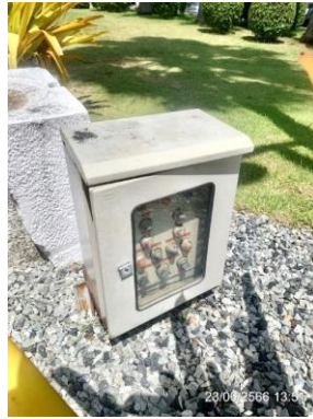
เครื่องสูบน้ำสำหรับระบายน้ำสู่ท่อระบายสาธารณะ ด้านหน้าโครงการ
