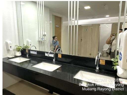
รูปที่ 2-20 ก๊อกน้ำอัตโนมัติ
