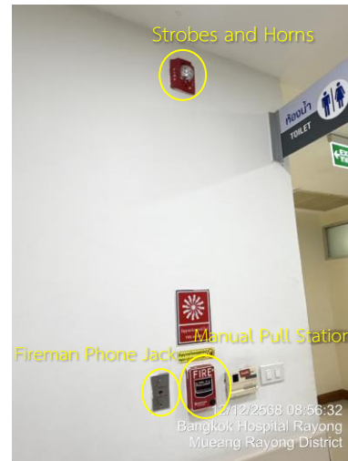
ชุดกดแจ้งเหตุแบบใช้มือดึง Manual Pull Station อุปกรณ์ส่งสัญญาณเสียง Strobes and Horns และจุดได้รับโทรศัพท์ (Fireman Phone Jack)
